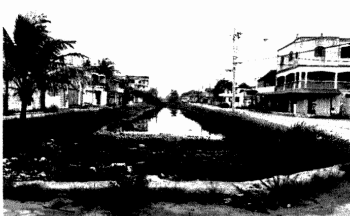
Intervenção importante para combater riscos de alagamento na região da Grande Terra Vermelha, a macrodrenagem do Canal do Congo depende de recursos federais. A obra chegou a começar em 2013, mas a Prefeitura de Vila Velha diz que houve problema nos repasses.
