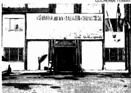
Prédio da Câmara de Cariacica será reformado
